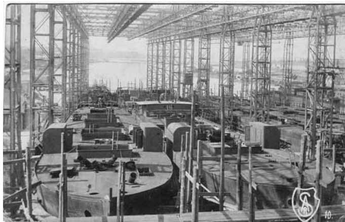
Корпуси десантних пароплавів типу «Ельпидифор» на стапелях № 1 та № 2 заводу «Руссуд». 1918 рік
